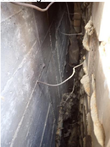
Abb. 18 Zuganbindung Vormauerschale durch gekrümmte Anker!
